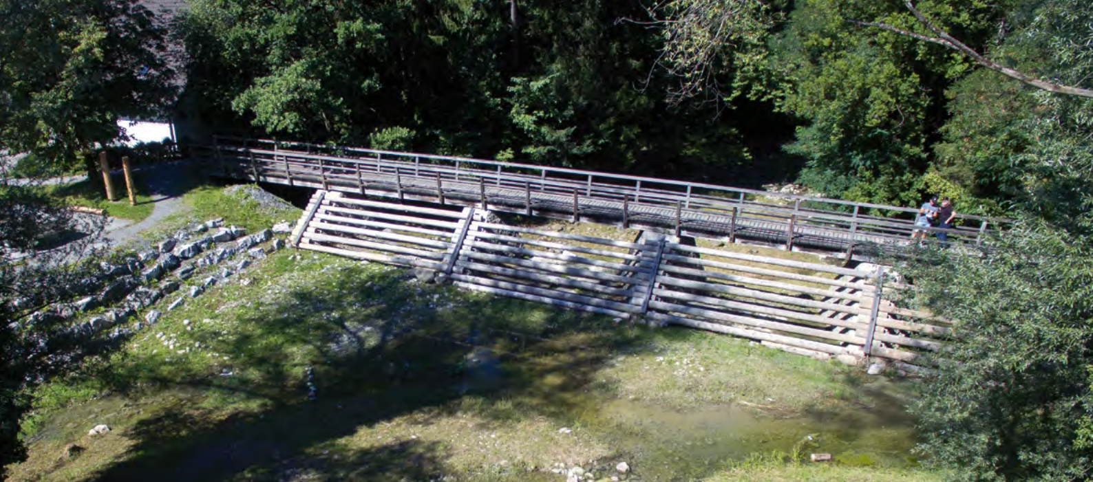
Die Rechen dienten dazu, die geflößten Holzstämme aufzuhalten
